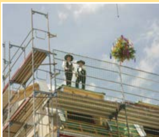
5. Juni 2014 Es wird Richtfest gefeiert, nachdem Rohbau und Dachstuhl fertiggestellt sind.
