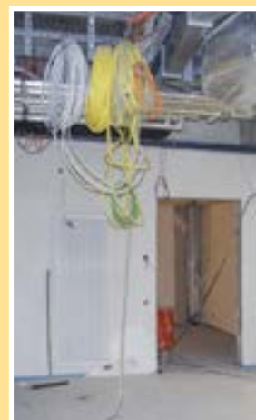
5. Februar 2015 Die Innenausbauarbeiten Januar 2015
