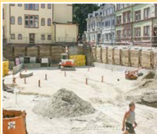
23. August 2013 Die Baugrube für den zweiten Bauabschnitt des Marienhauses ist fertiggestellt.
