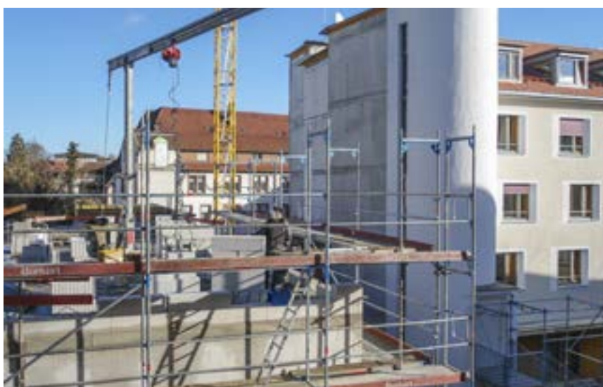
Der erste Ersatzneubau des Marienhauses (rechts im Bild) ist bereits fertiggestellt und bezogen, als mit dem Bau des zweiten Teilabschnitts begonnen wird.
