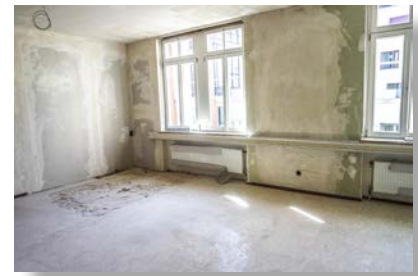
Bild oben: Sanierung des Historischen Gebäudes
